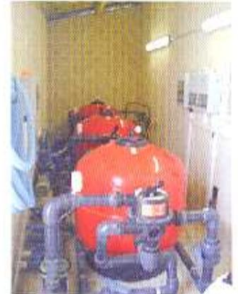
Filtration équipée de débitmètre et d'alarme sonore de colmatage
