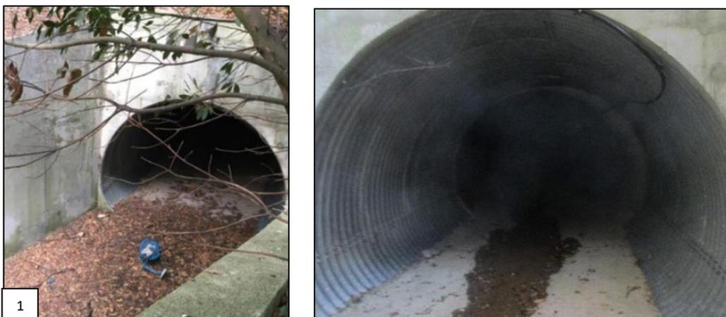
Figure 6 : Entrée de la buse à rebâtir
