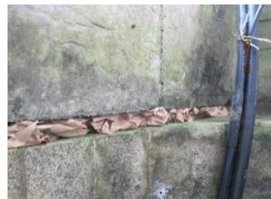
En haut : Exemple de colmatage d'un drain avec du papier journal et sécurisé avec un ruban adhésif
