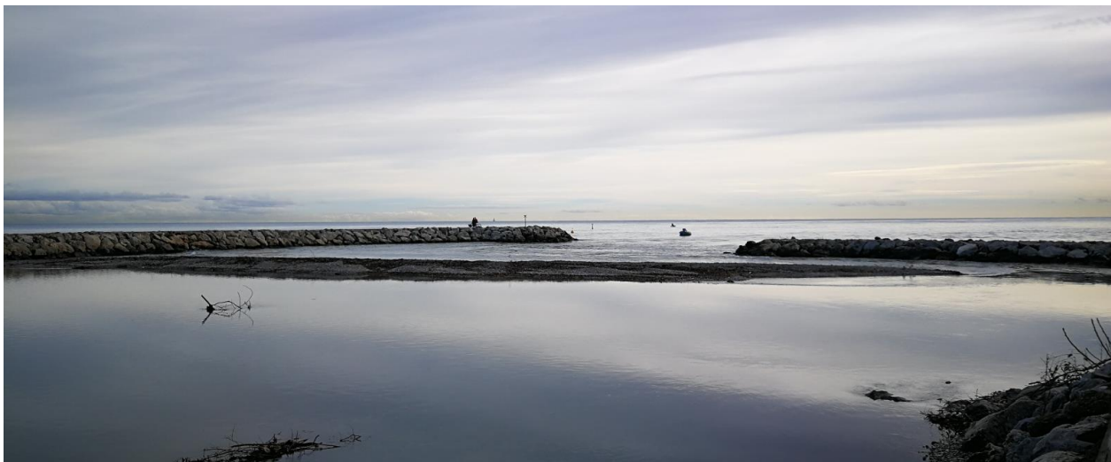
Illustration 20 : Le bouchon sableux vu vers l'aval
