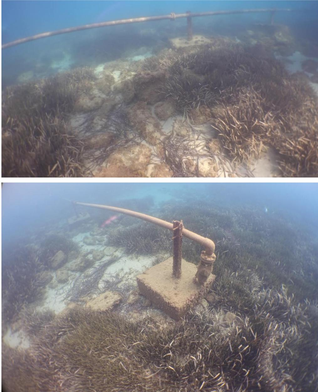
Figure 26 : Conduite et crépine d'aspiration montées sur corps morts
