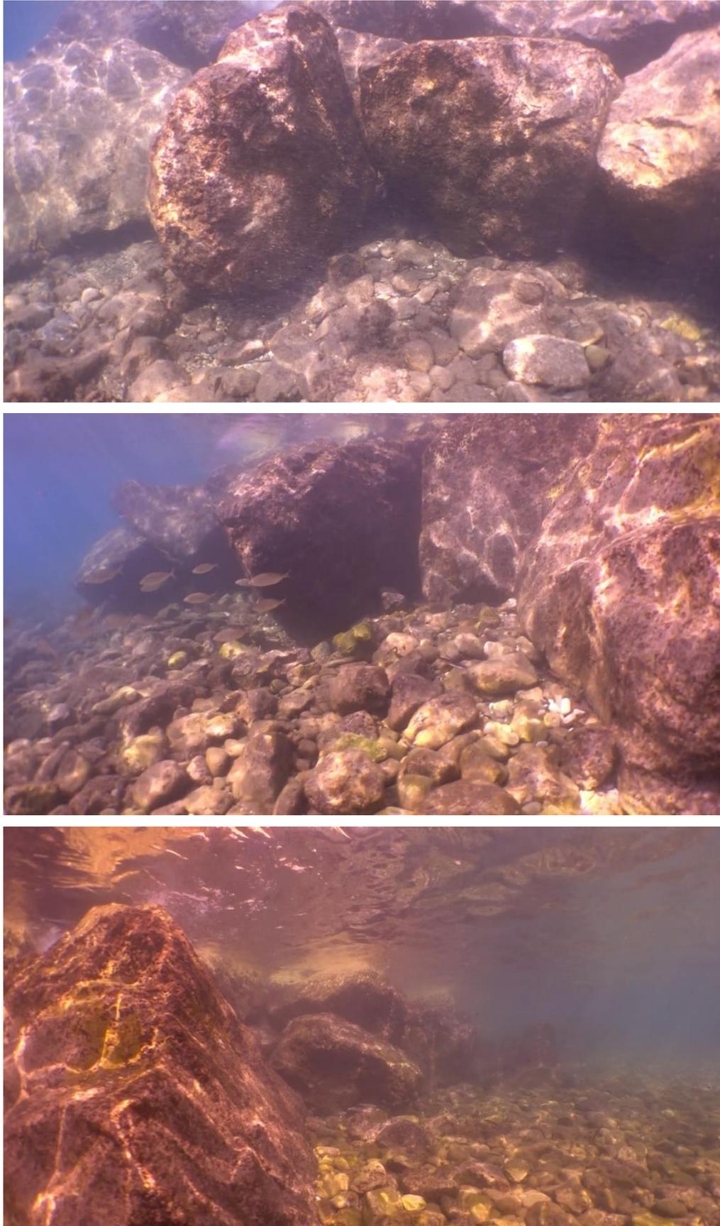
*Figure 39: Enrochements provisoires de couronnement sur galets décimétriques*
