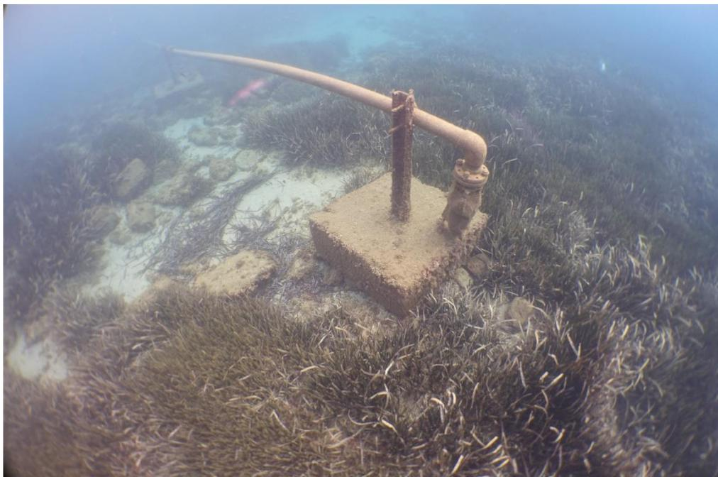
Figure 51 : Conduite et crépine d'aspiration montées sur corps morts
